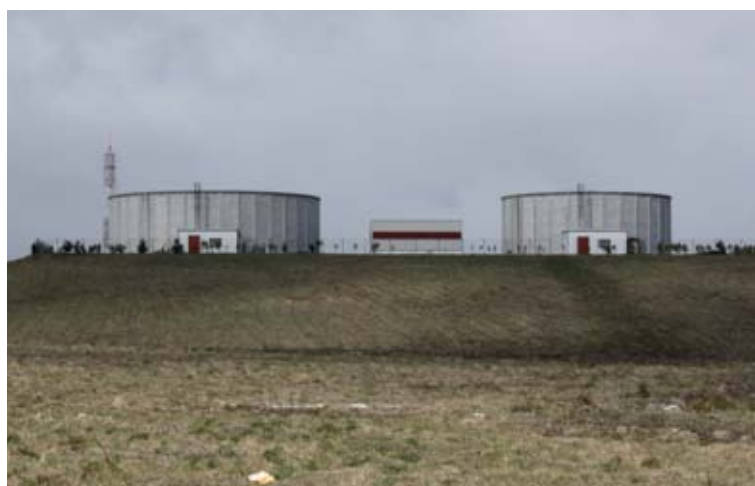
Depósitos de auga do polígono industrial de Teixeira (Curtis)
