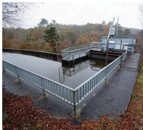
Cámara de carga da central da Castellana (Aranga)
