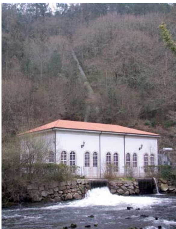
Central hidroeléctrica Mandeo-Zarzo (Paderne)
