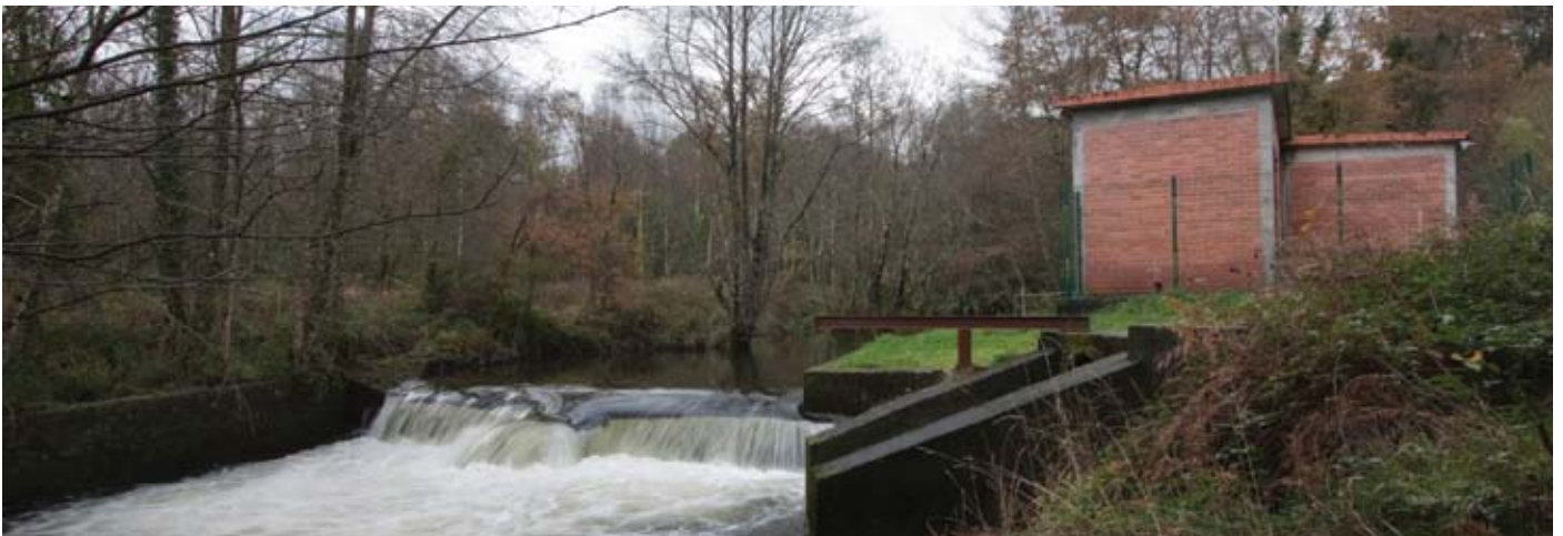
Captación de auga en Teixeira (Curtis)
