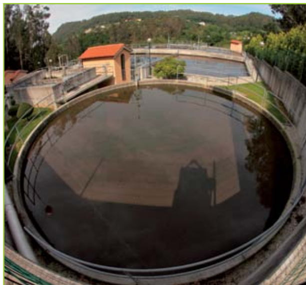
EDAR de Coirós
