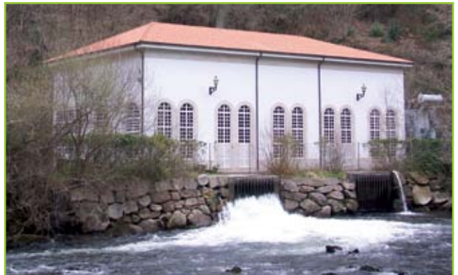
Central hidroeléctrica Mandeo-Zarzo
